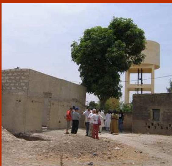
Station de pompage de Peycouck et maison du gardien
